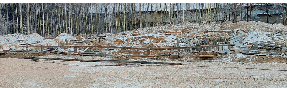
Plac Budowy Remizy OSP w Kowala-Stępocinie
