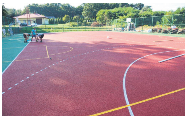
Remont boiska w Kosowie
