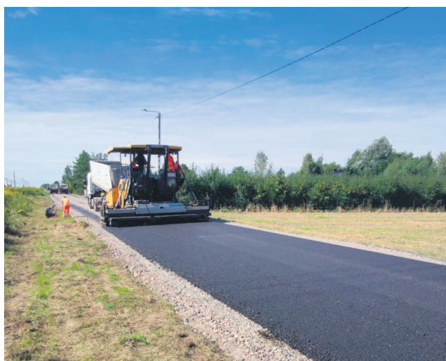
Przebudowa drogi w Ludwinowie.
