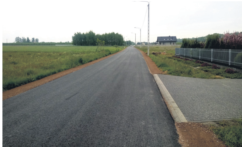
Wyremontowana droga w Kowali Kolonia
