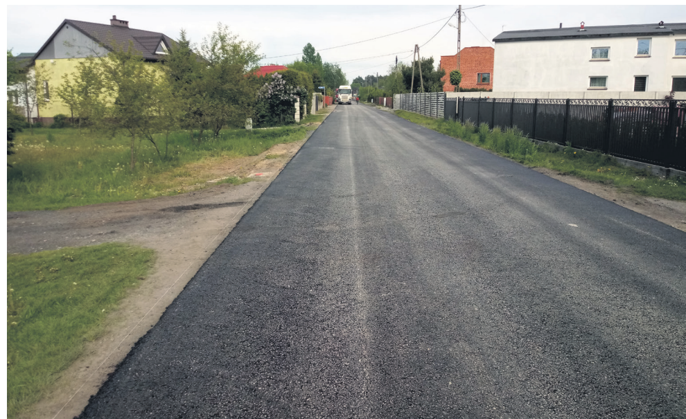
Droga w Zabierzowie z nową nawierzchnią
