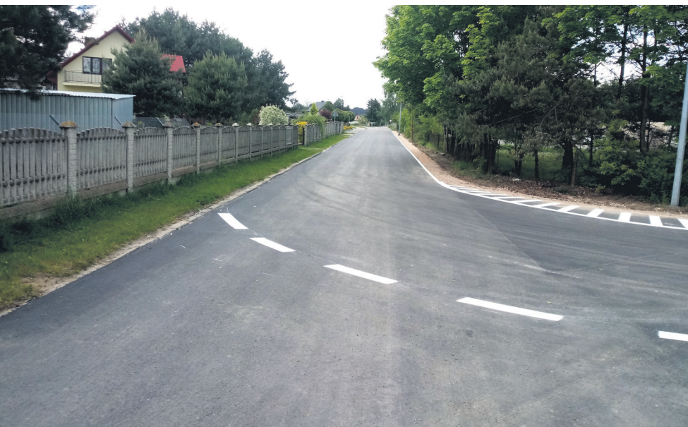
Wyremontowana droga w Kowali
