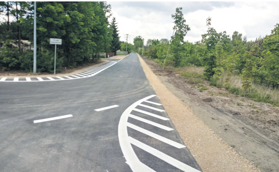
Wyremontowana i poszerzona droga wewnętrzna w Kowali
