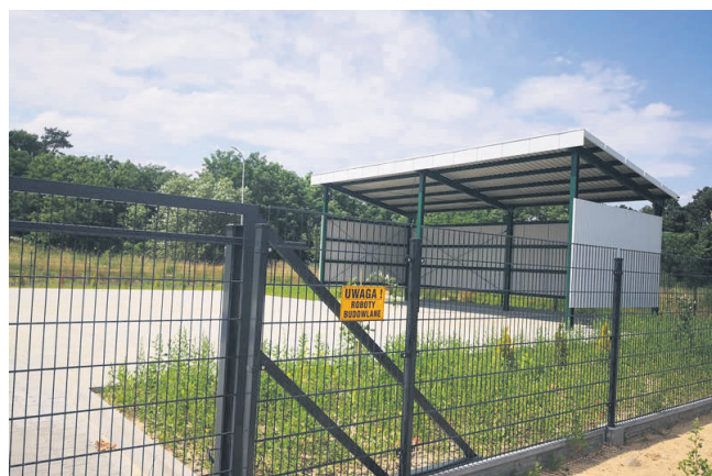
Plac Budowy PSZOKu w Kosowie
