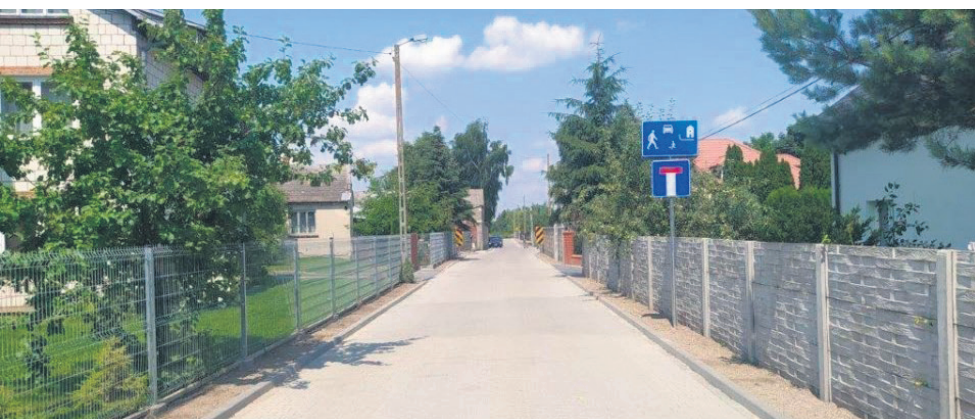
Ciąg pieszo-jezdny w miejscowości Mazowszany
