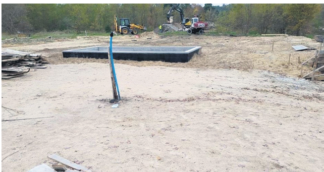
Plac budowy Punktu Selektywnej Zbiórki Odpadów Komunalnych w Kosowie
