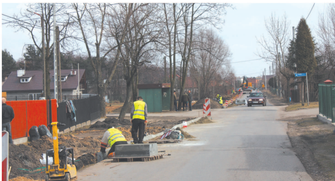
Trwa budowa drogi z Trablic do Ludwinowa
