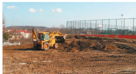
Rozpoczęła się budowa muszli koncertowej tuż obok nowoczesnego obiektu sportowego
