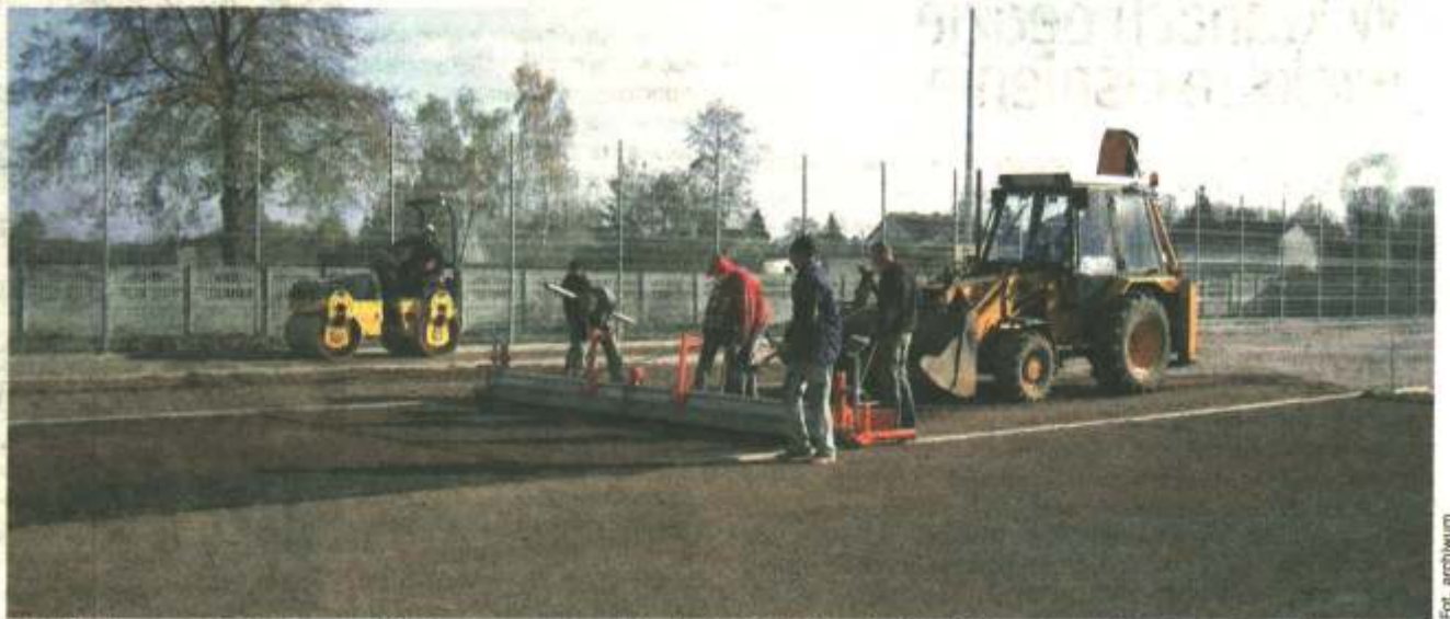
Robotnicy pracują teraz przy układaniu nowej nawierzchni boisk koło szkoły w Mazowszanie.
