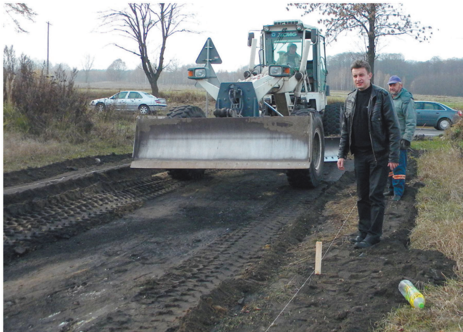
■ Dariusz Chruślak, radny gminy Kowala, dogląda budowy drogi w Kolonii Parznice
