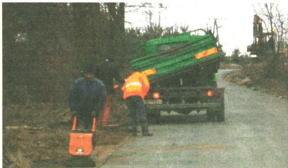
W Trablicach trwają już prace przy utwardzaniu poboczy.
