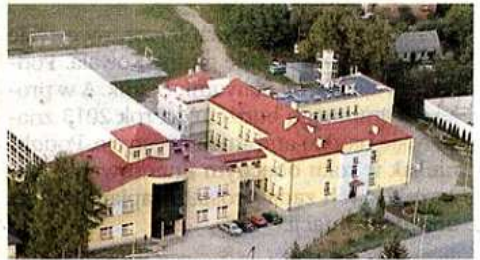
Budynek Publicznej Szkoły Podstawowej w Kowali dzięki termomodernizacji zyskał nowy wygląd.
