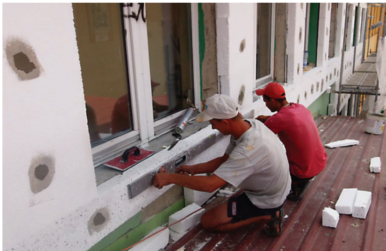
W Publicznym Gimnazjum w Parznicach ekipy remontowe ocieplą budynek.
