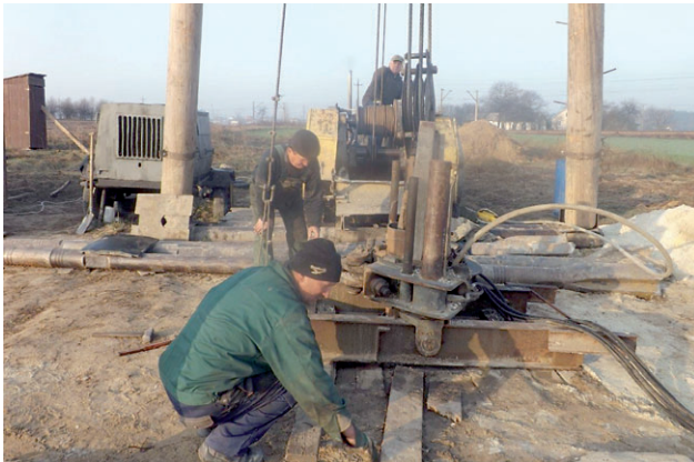
Budowa ujęcia wody w Dąbrówce Zabłotniej.
