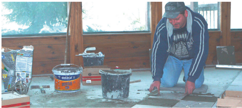
Wymiana posadzki w ośrodku zdrowia przebiega bardzo sprawnie.
