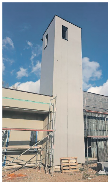
Budowa Remizy Strażackiej w Kowali-Stępcinie
