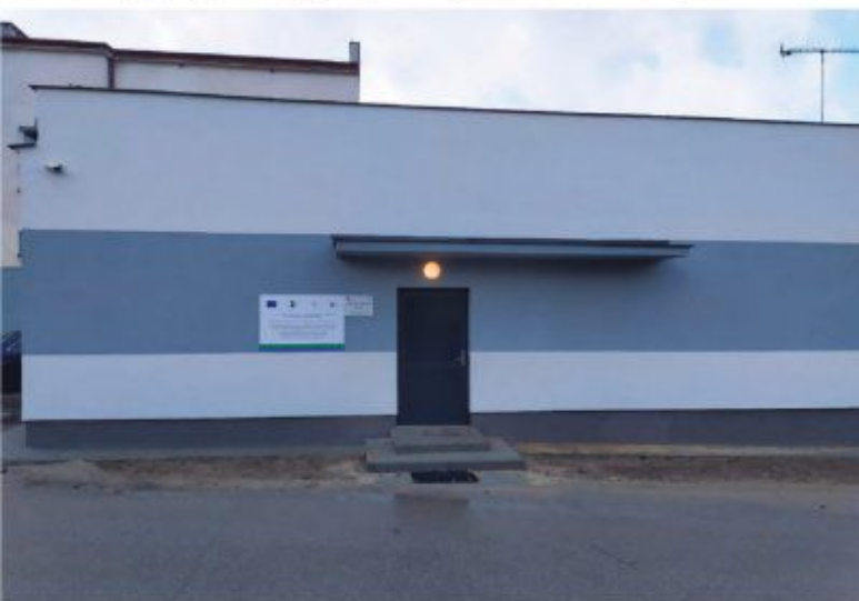
Fotowoltaika i termomodernizacja świetlicy Szansa w Kowali
