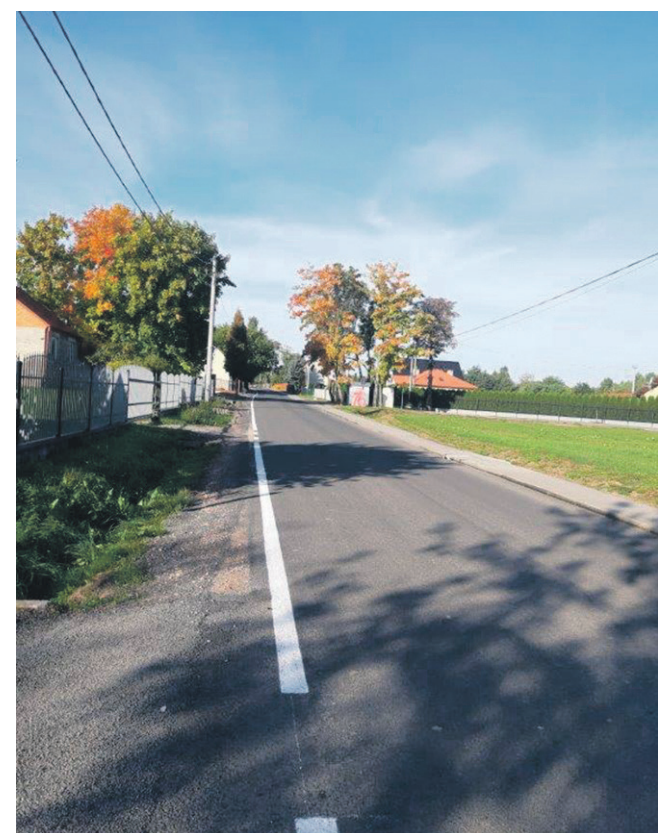
Wyremontowana droga w miejscowości Trabllice
