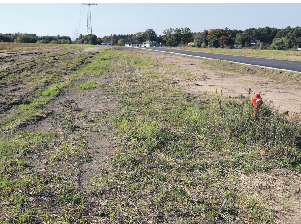
Budowa sieci wodociągowej w miejscowości Kosów
