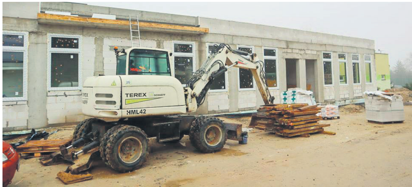
Budowa Przedszkola przy PSP w Mazowszanych
