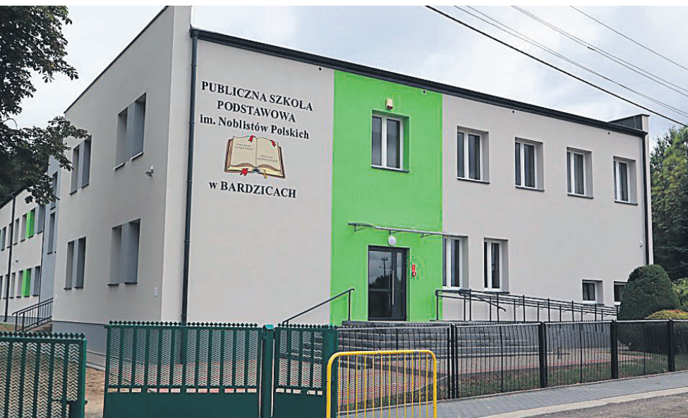
Termomodernizacja budynku PSP w Bardzicach.
