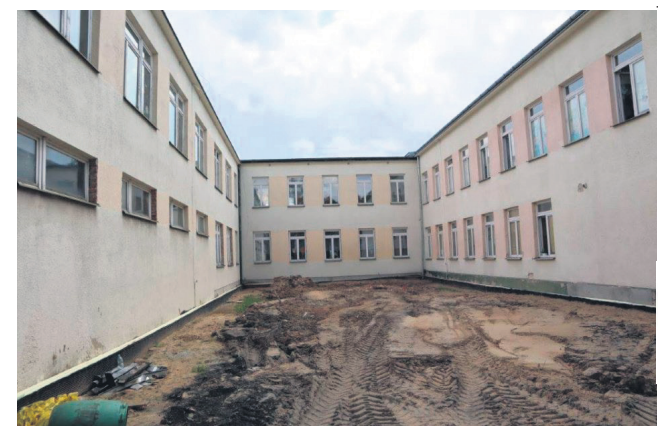
Termomodernizacja budynku PSP w Mazowszanach
