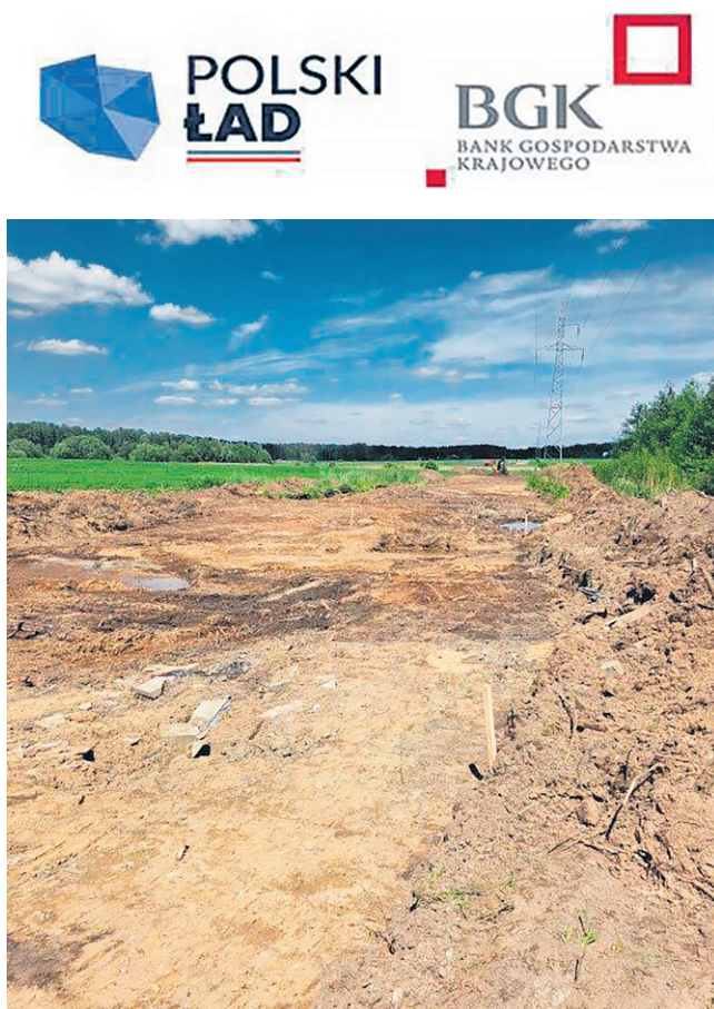
Budowa drogi w miejscowości Kosów
