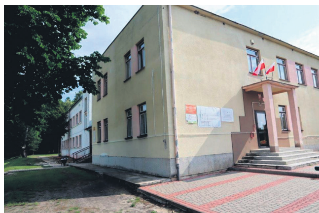
Termomodernizacja budynku PSP w Bardzicach
