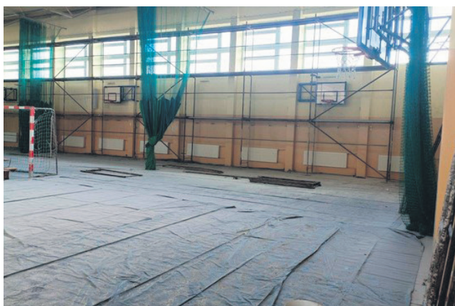
Remont hali sportowej przy PSP w Parznicach
