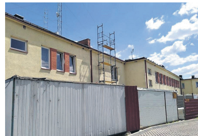
Termomodernizacja budynku PSP w Młodocinie Mniejszym
