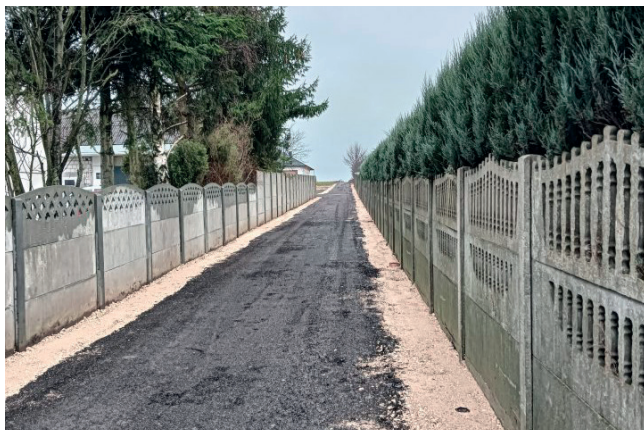
Droga gminna w miejscowości Mazowszany
