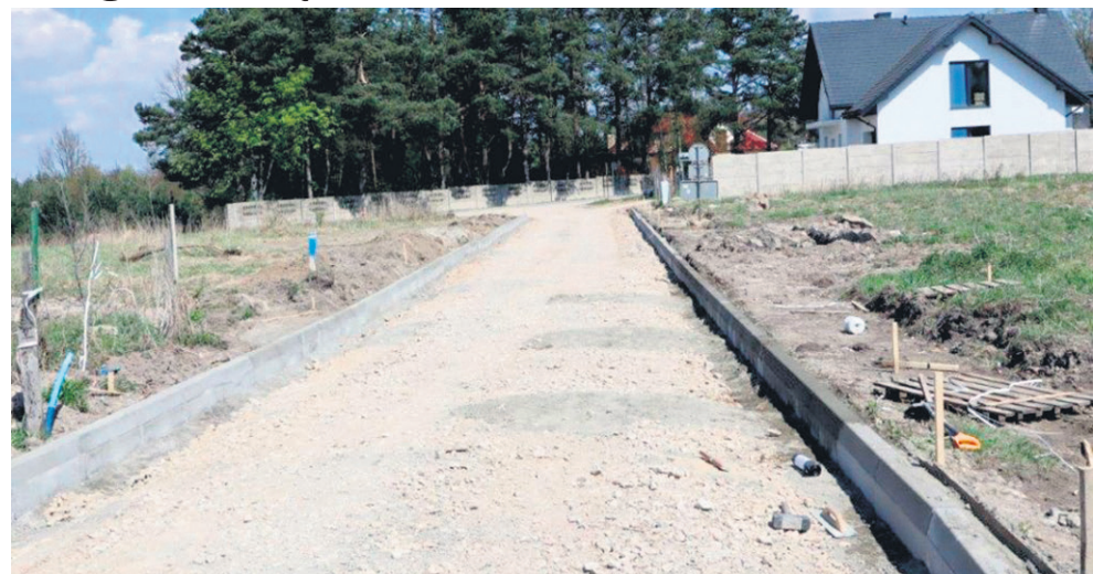
Budowa drogi wewnętrznej w miejscowości Kosów
