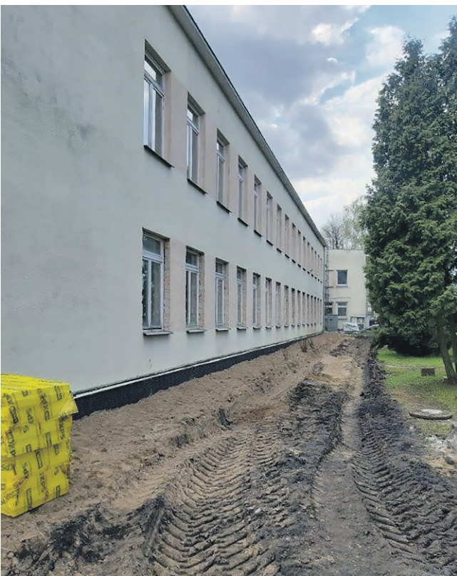
Prace termomodernizacyjne przy PSP w Mazowszanach
