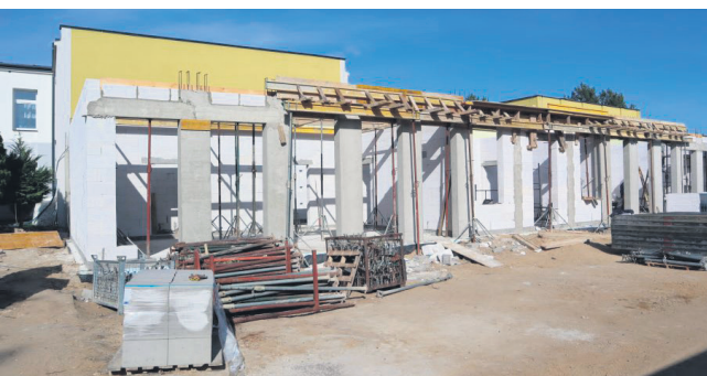
Budowa przedszkola przy PSP w Mazowszanach
